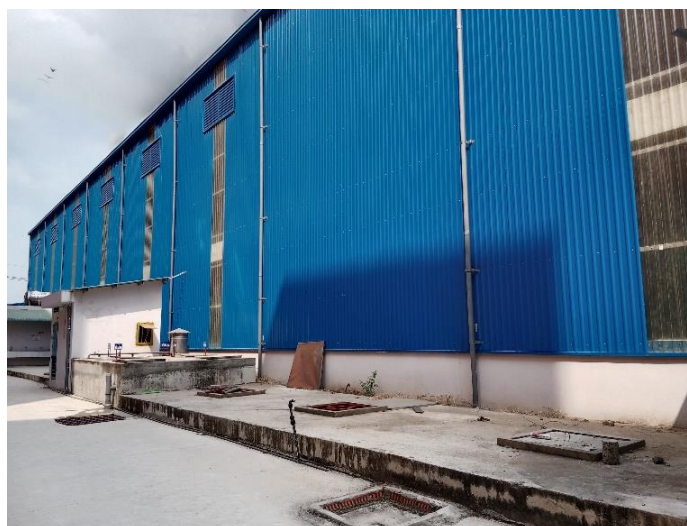
Hình 3.8. Hình ảnh khu vực HTXL nước thải sinh hoạt và bể chứa nước sản xuất
