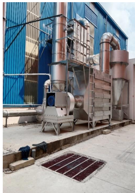
d. Hình ảnh HTXL khí thải
