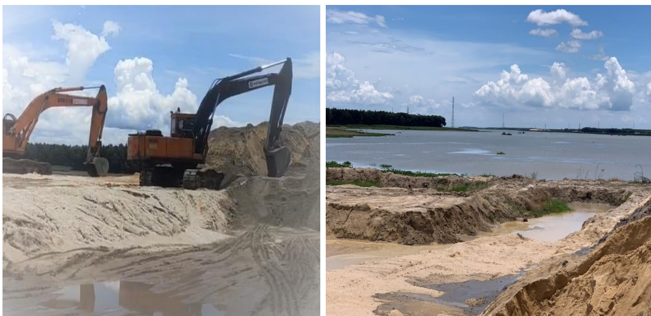
Hình 3.5. Hình ảnh thu gom, thoát nước thực tế tại cơ sở
