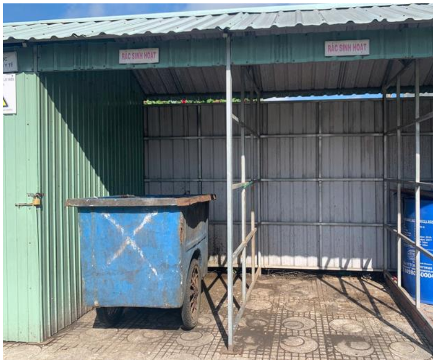
Hình 3.7: Khu vực tập kết chất thải rắn sinh hoạt
