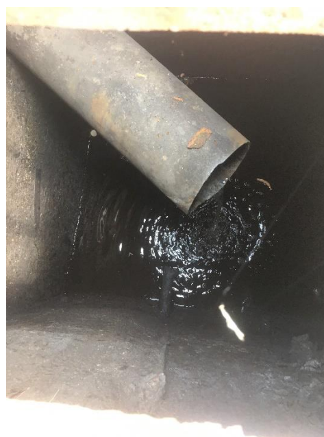
Hình 3.6: Vị trí điểm đầu nối nước thải sinh hoạt trên đường số 2
