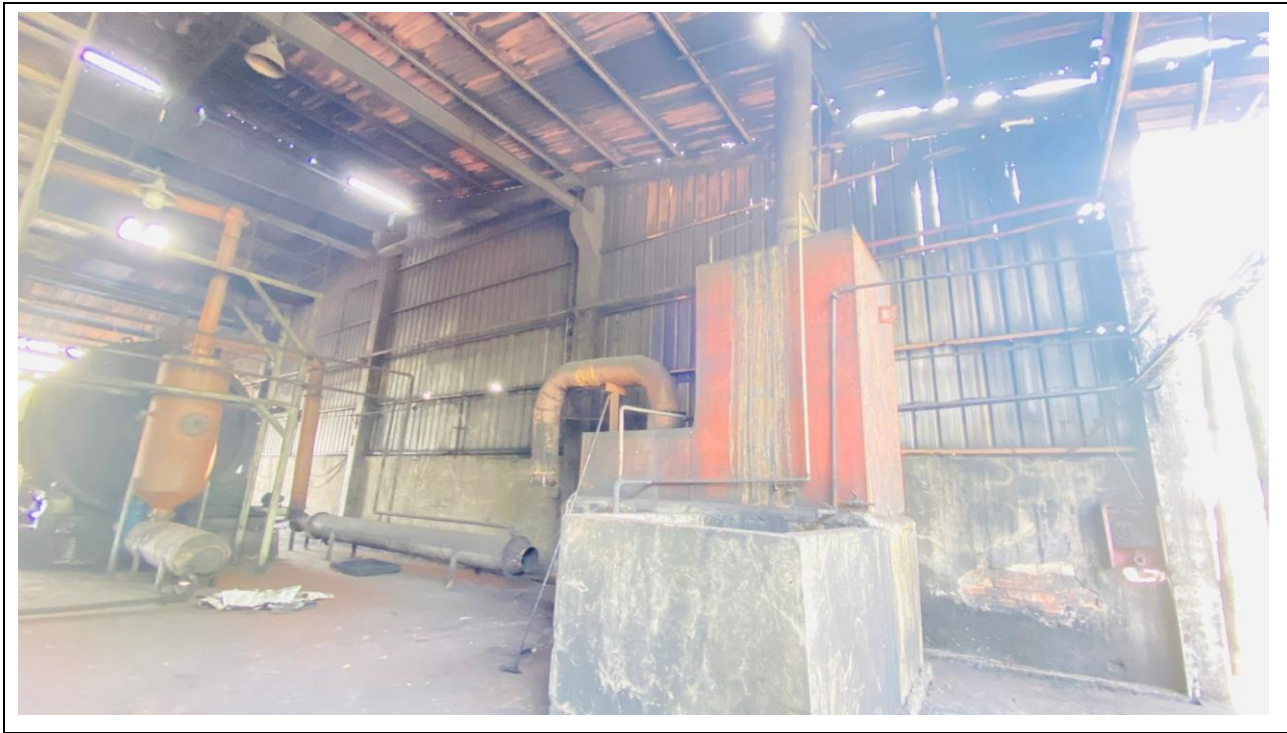
Hình 3.9. Hình ảnh tháp hấp thụ xử lý khí thải buồng đốt
