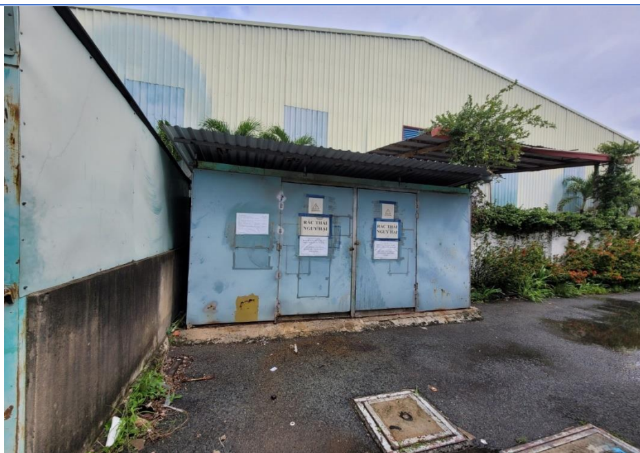
Hình 3.13: Kho rác thải nguy hại tại cơ sở
