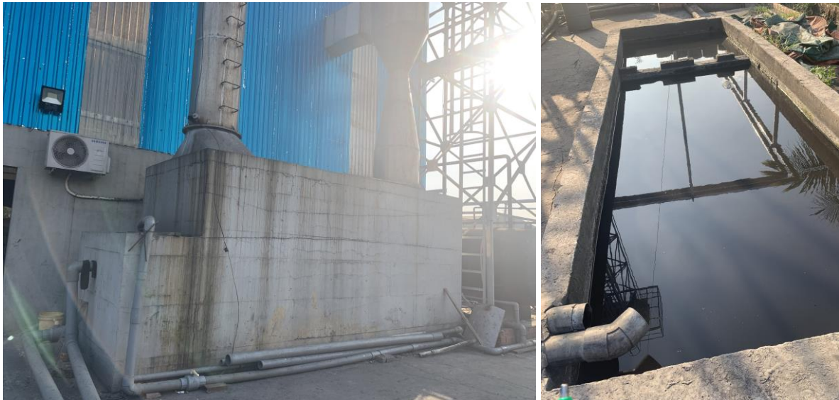
Hình 3.3: Đường ống xả đáy bể chứa dung dịch hấp thụ và bể trung gian
