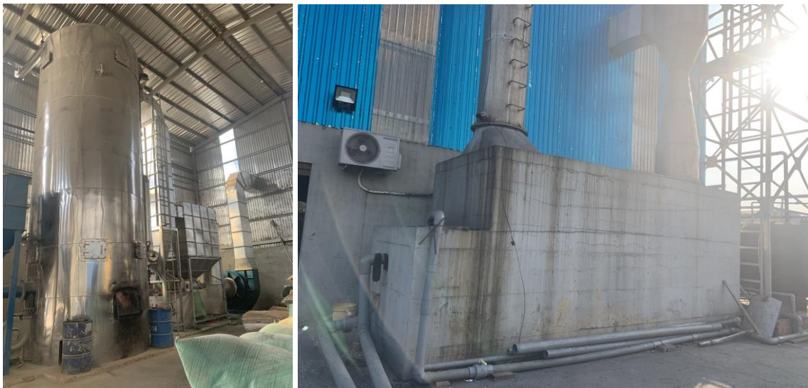
Hình 3.13: Lò dầu truyền nhiệt và hệ thống xử lý bụi, khí thải
