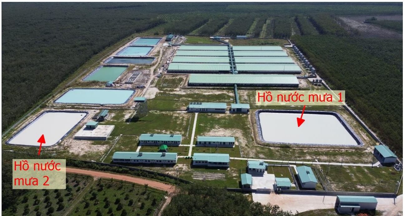
Hình 3. 2 Hai hồ chứa nước mưa
