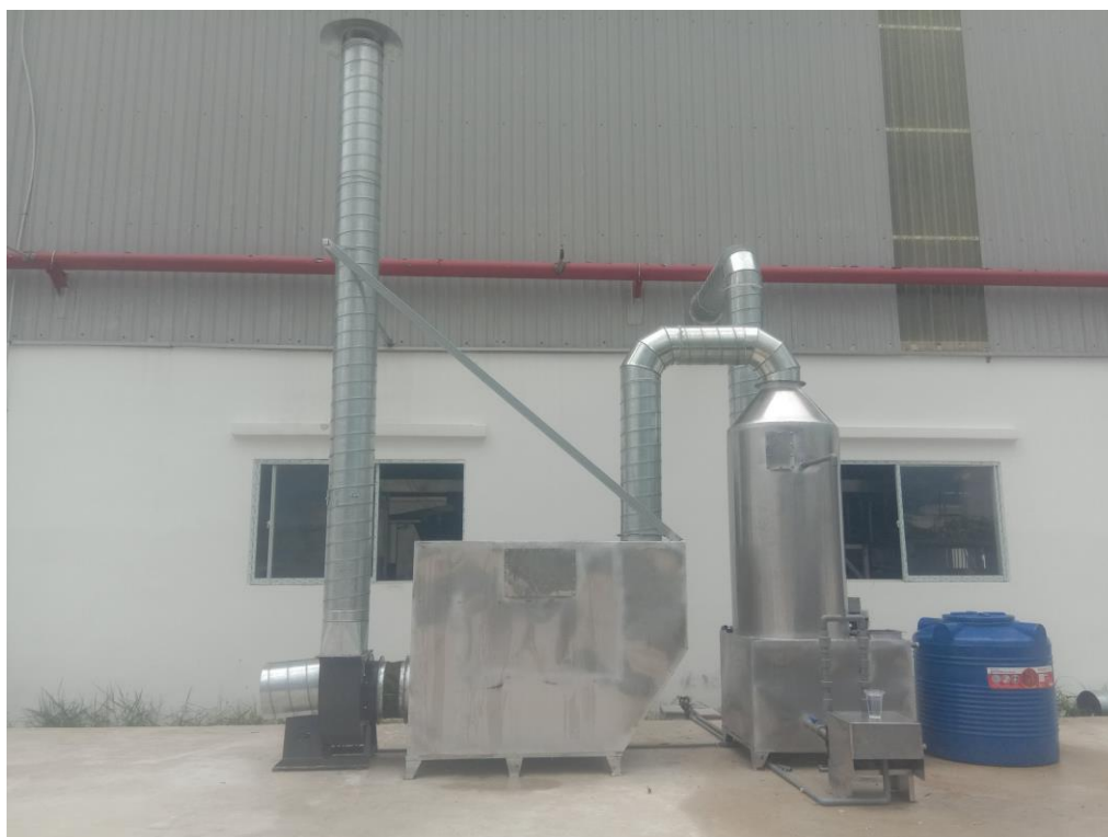
Hình 13: Một số hình ảnh hệ thống xử lý khí thải của Nhà máy
