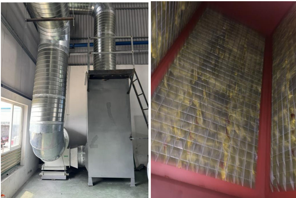
Hình 3.10: Thiết bị hấp phụ và lớp than hoạt tính bên trong
