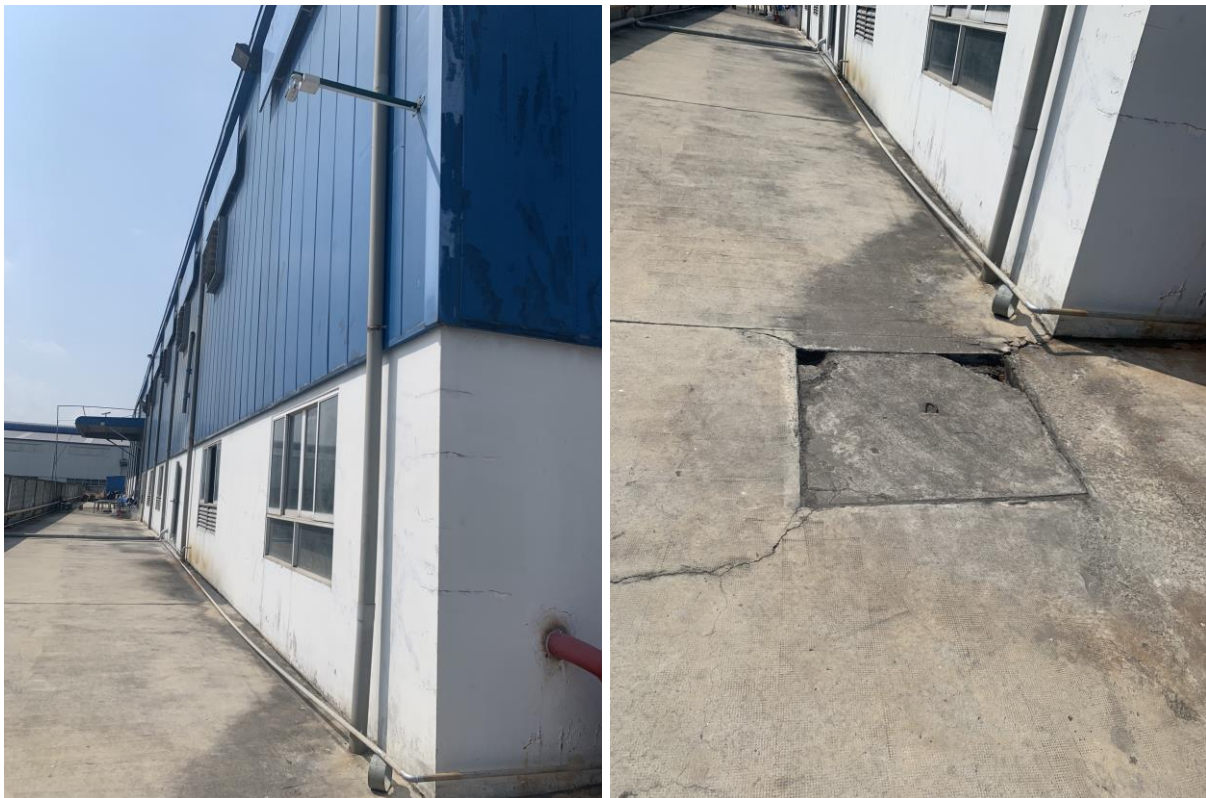
Hình 3.2: Hệ thống thu gom nước mưa trên mái và hồ ga thu nước mưa
