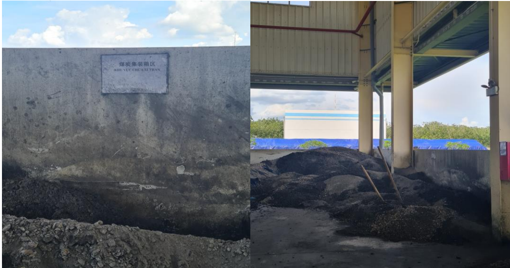
Hình 3. 14: Khu vực chứa xỉ than của nhà máy
