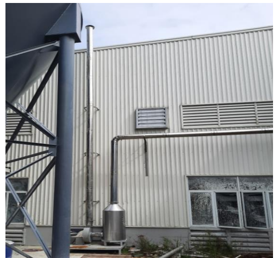
Hình 3. 15: Bồn pha keo và hệ thống xử lý hơi dung môi từ công đoạn pha keo
