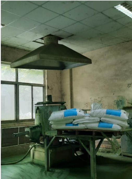
Hình 3. 18: Hệ thống xử lý bụi tại công đoạn pha bột màu
