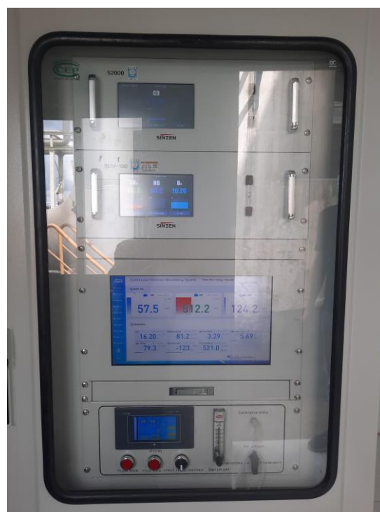
Hình 3. 19: Trạm quan trắc khí thải tự động, liên tục của dự án
