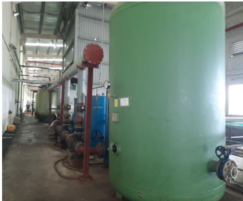
Hình 3. 11: Hệ thống xử lý nước mềm
