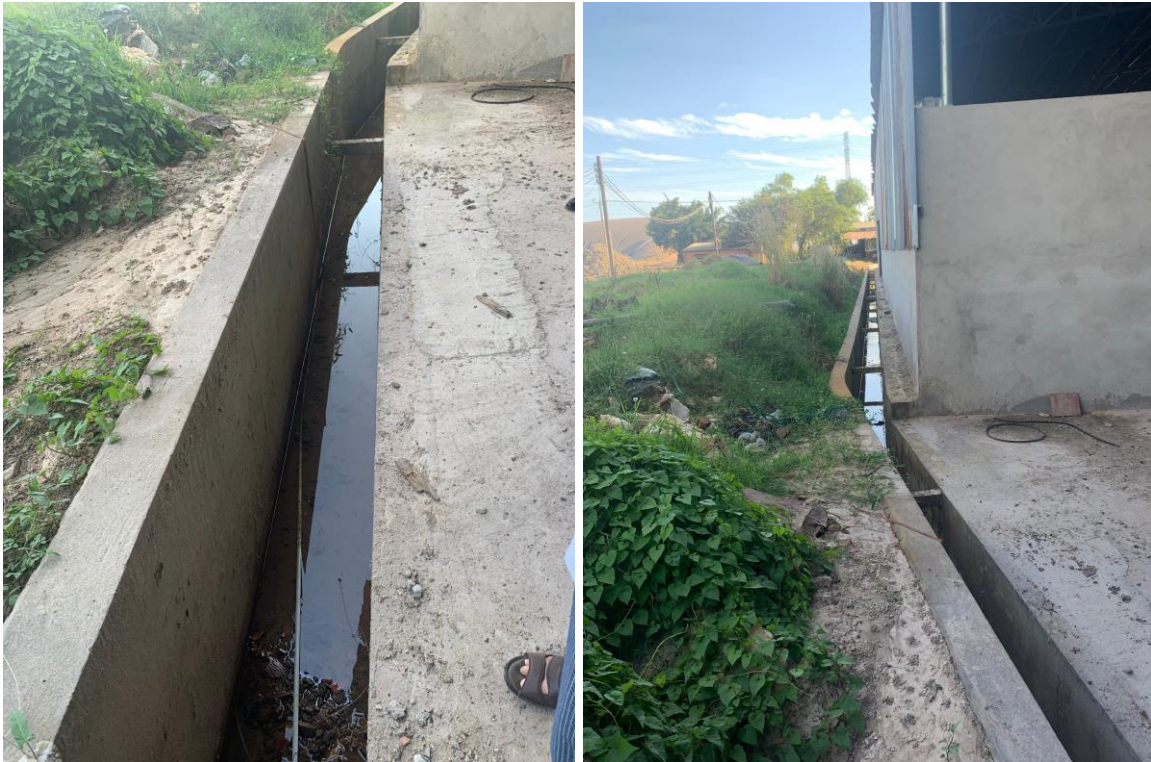
Hình 3.1: Mương thu gom và thoát nước mưa tại Nhà máy
