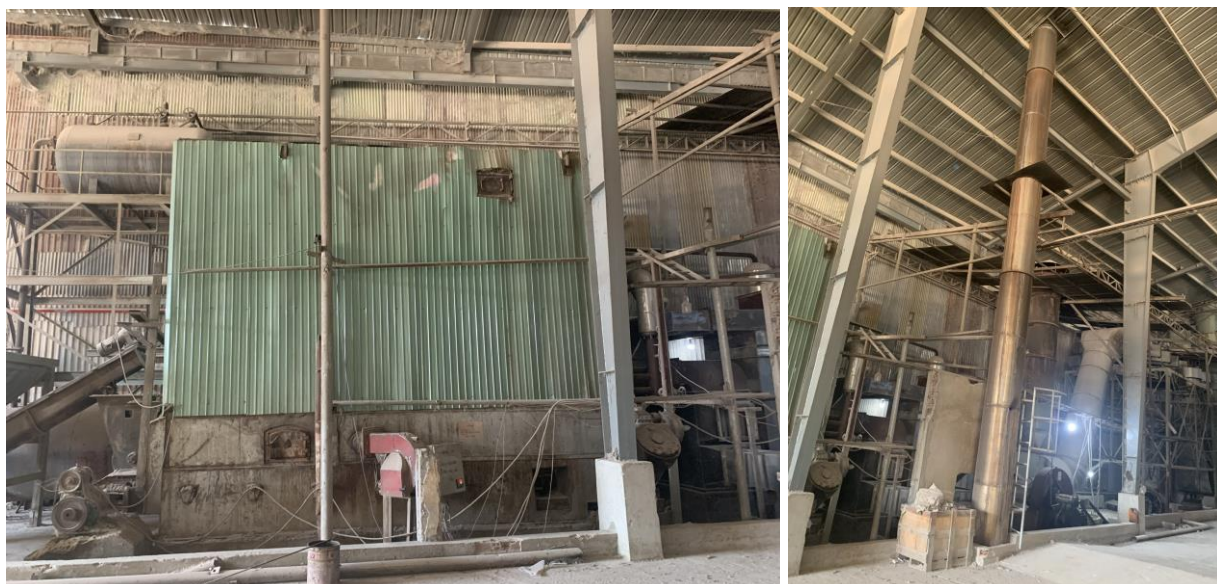
Hình 3.10: Lò dầu truyền nhiệt công suất 6.000.000 kCal/giờ
