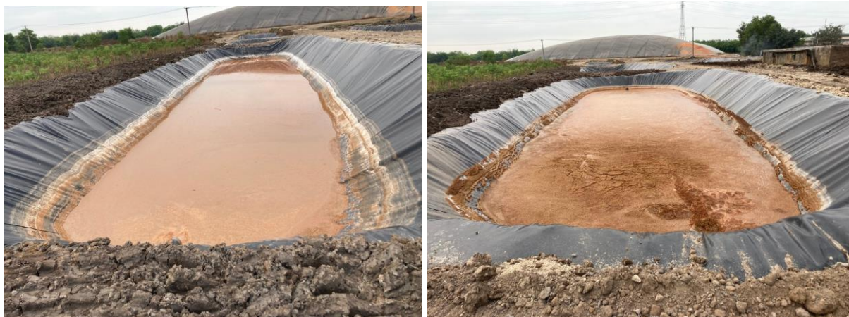
Hình 3.4: Cụm bể lắng cát tại Nhà máy
