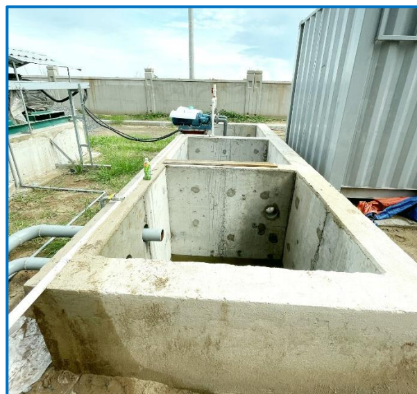
Hình 3.3 Ảnh hệ thống xử lý khí thải lò hơi đã lắp đặt
