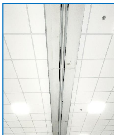
Hệ thống miệng cấp gió làm mát xưởng
