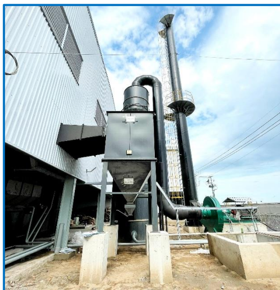
Hình 3.3 Ảnh hệ thống xử lý khí thải lò hơi đã lắp đặt
