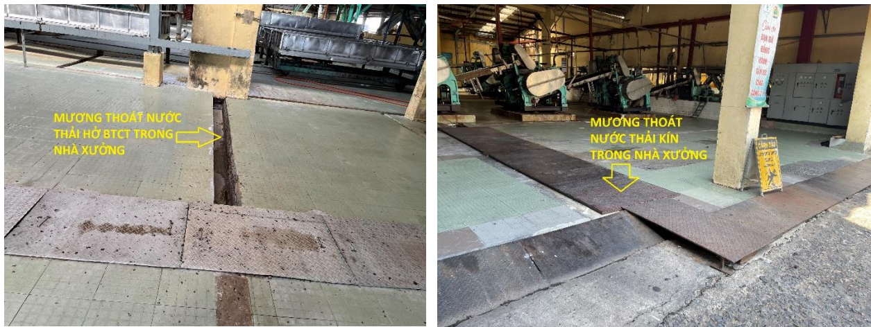
Hình 3. 4: Hiện trạng thu gom nước thải tại Nhà máy.
