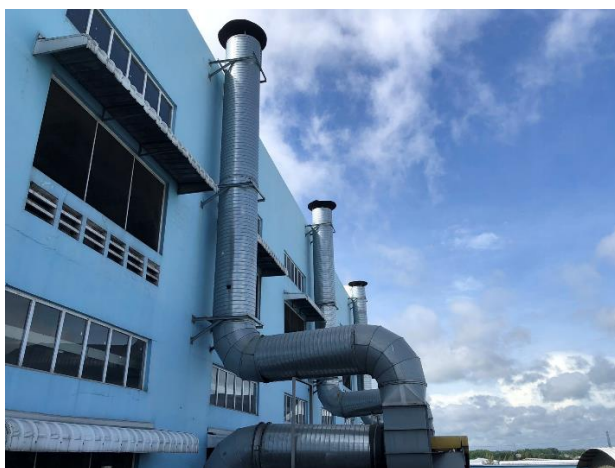
Hình 3.12 Ống thoát nhiệt từ công đoạn trộn cao su
