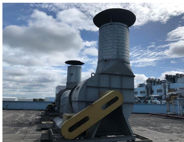
Hình 3.12 Ống thoát nhiệt từ công đoạn trộn cao su
