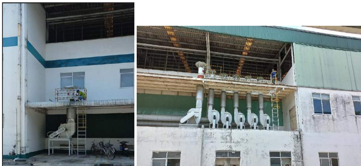
Hình 3. 13 - Hình ảnh của 11 công trình HTXL hơi hóa chất được thug om thoát ra ngoài môi trường
