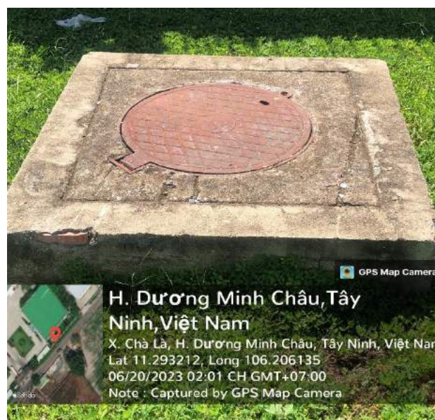
Hình 3. 2 - Hình ảnh hố ga đấu nối thoát nước mưa của dự án với KCN Chà Là
