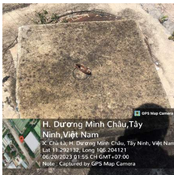
Hình 3. 2 - Hình ảnh hố ga đấu nối thoát nước mưa của dự án với KCN Chà Là
