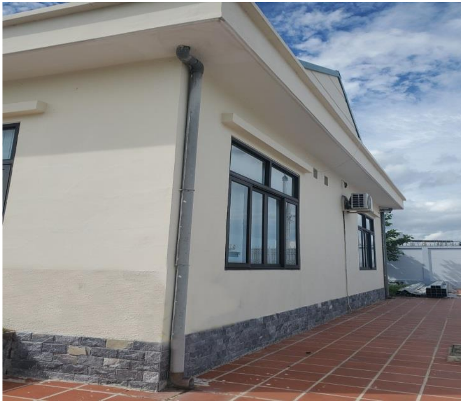
Hình 3. 2. Đường ống thoát nước mưa trên mái tại cơ sở
