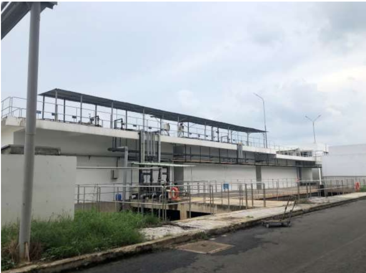
Hình 3. 4 – Hình ảnh công trình HTXL nước thải tập trung của Dự án
