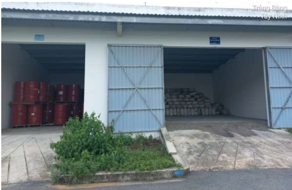
Hình 3. 11 – Hình ảnh nhà chứa rác của Dự án
