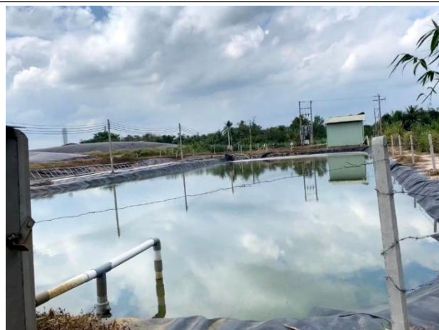
Bể chứa bùn
