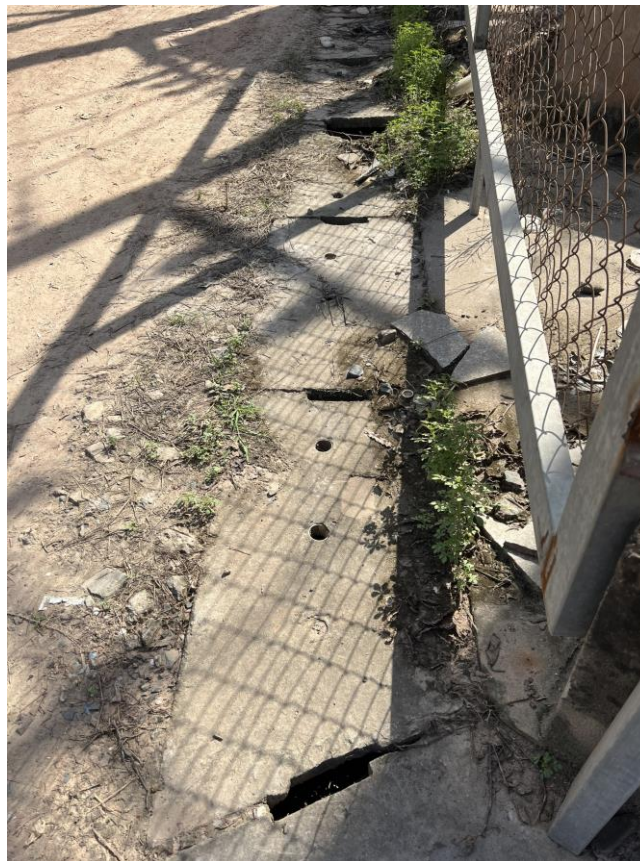
Hình 3.1: Mương thoát nước mưa tại Nhà máy
