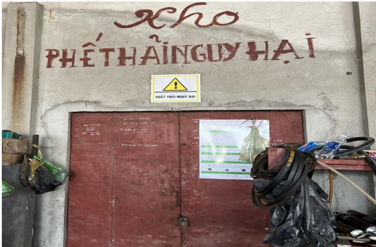
Hình 3.11: Kho chứa chất thải nguy hại tại Nhà máy
