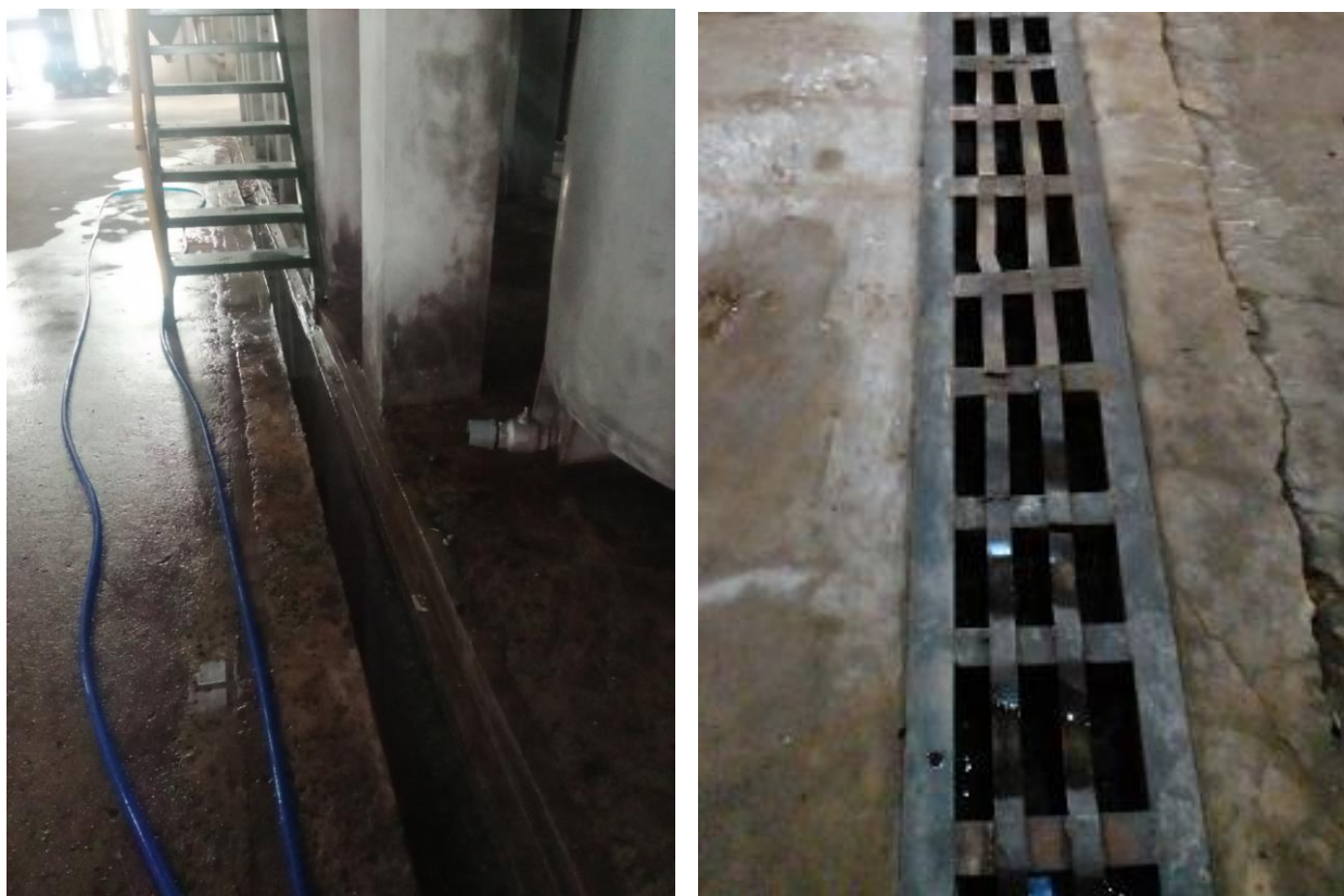
Hình 9. Mương dẫn nước thải
