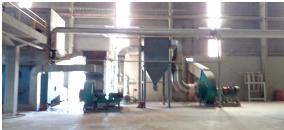
Hình 17. Hình ảnh lò dầu tải nhiệt của Nhà máy
