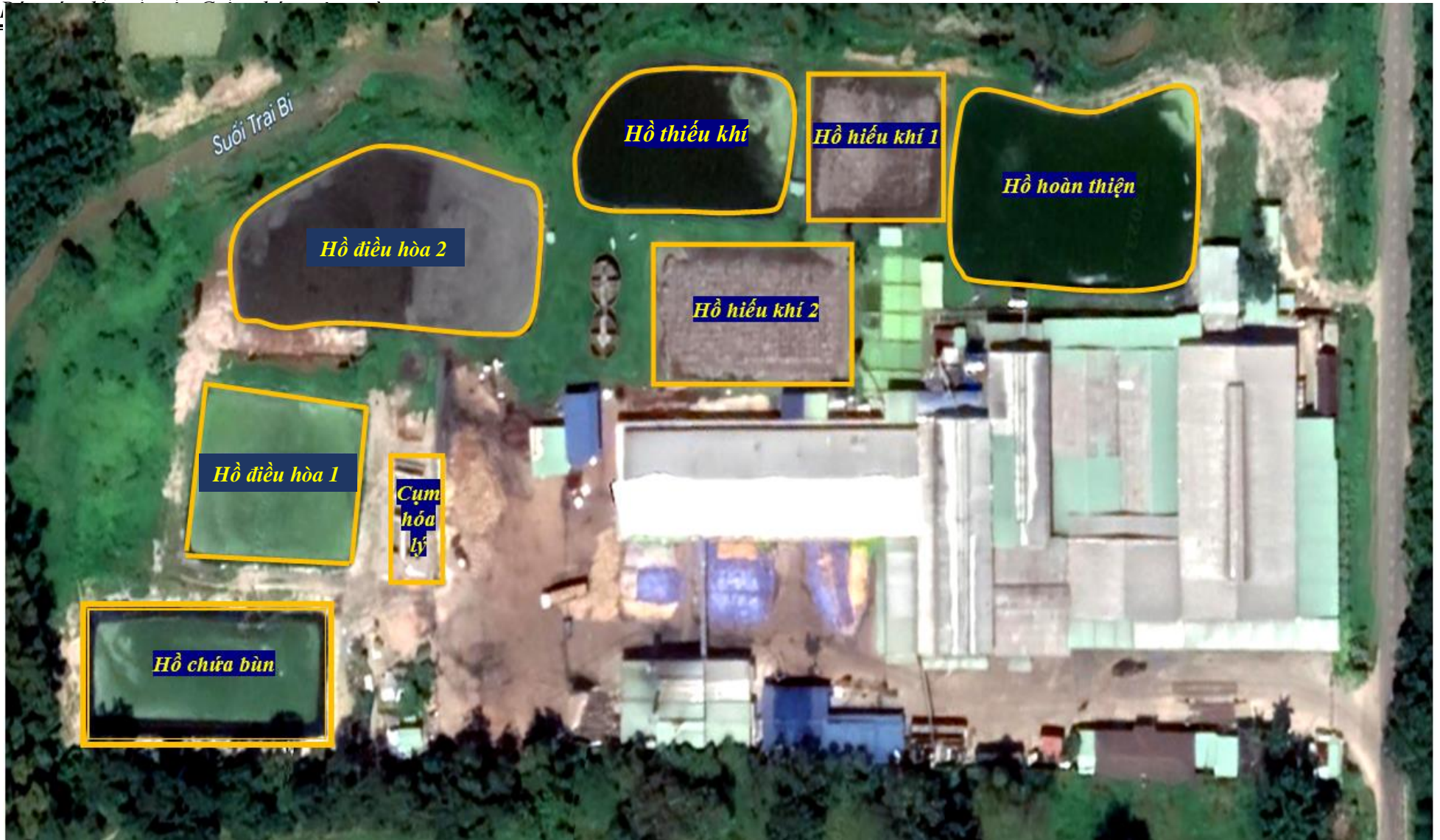
Hình 3.4. Toàn cảnh hệ thống xử lý nước thải của nhà máy
