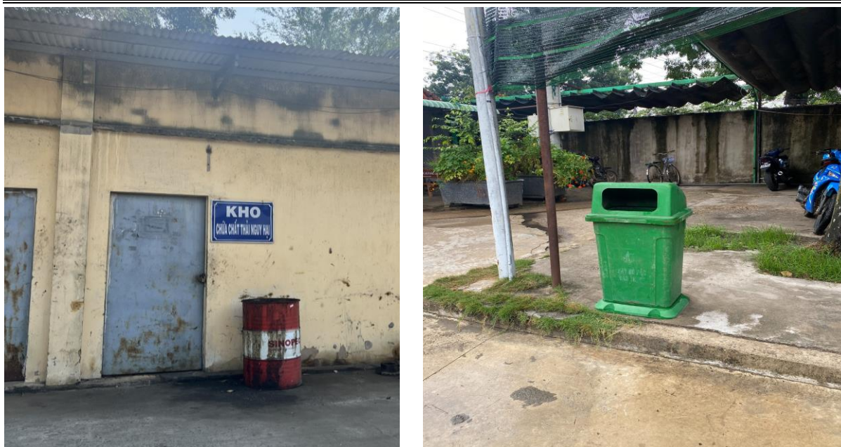
Hình 3.12. Khu vực chứa chất thải rắn sinh hoạt và kho chứa chất thải nguy hại
