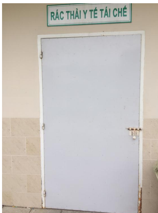
Hình 3.8: Hình ảnh kho chứa rác thải y tế tái chế (Kho chứa chất thải rắn công nghiệp thông thường)
