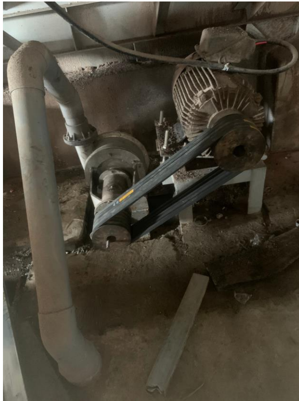
Hình 3.3: Bơm nước thải tại khu vực rửa củ
