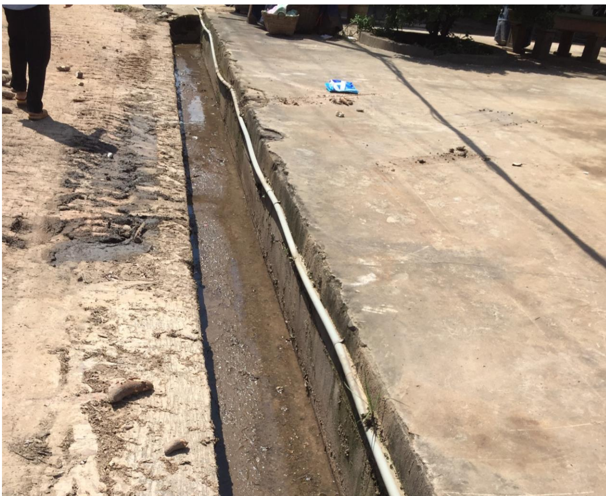
Hình 6. Mương bê tông thoát nước mưa tại dự án
