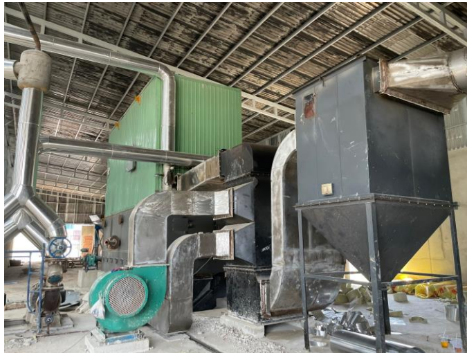
Hình 3.9. Lò dầu tải nhiệt
