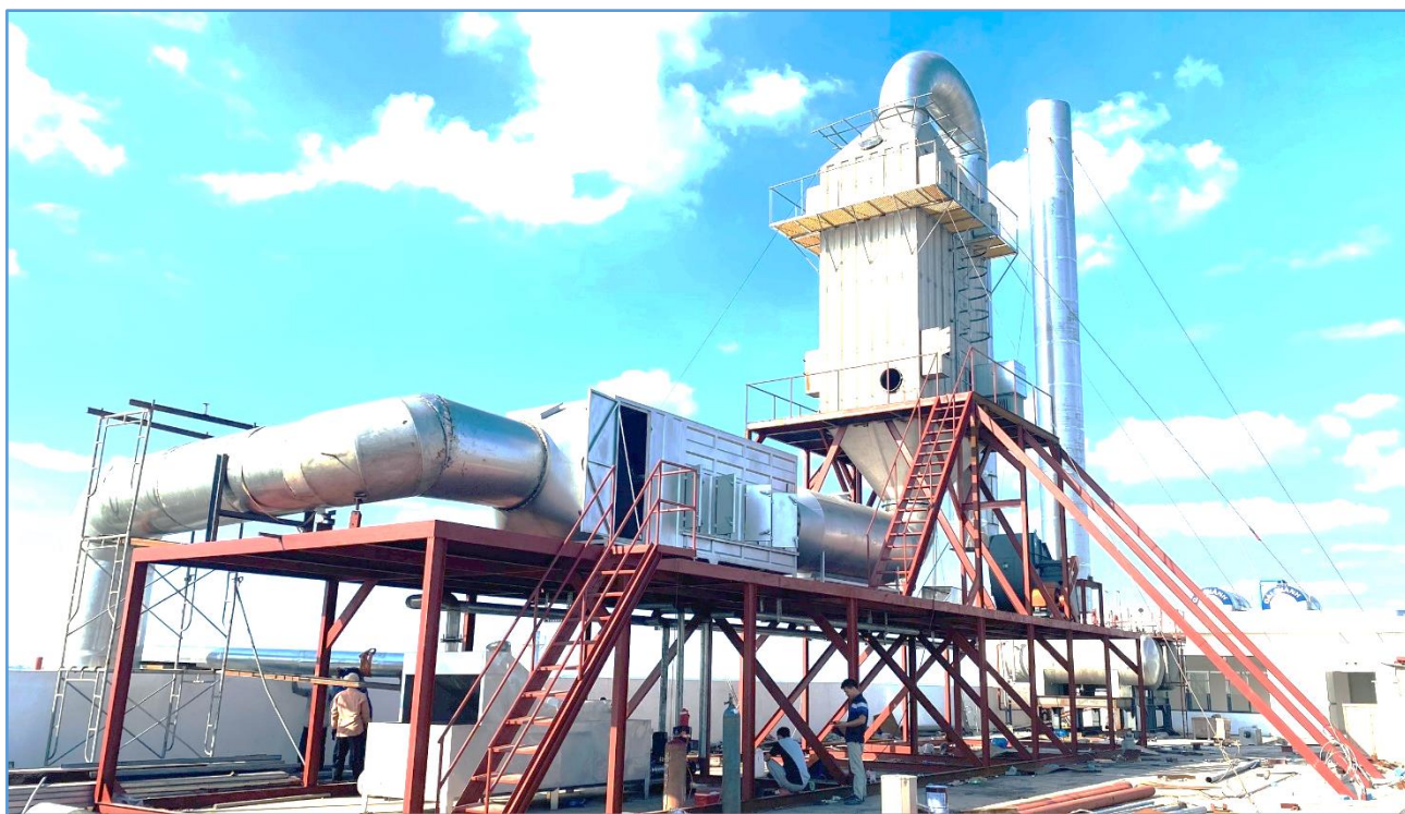
Hình 3.8 Ảnh ghi nhận thực tế công trình xử lý khí thải từ máy định hình tại dự án
