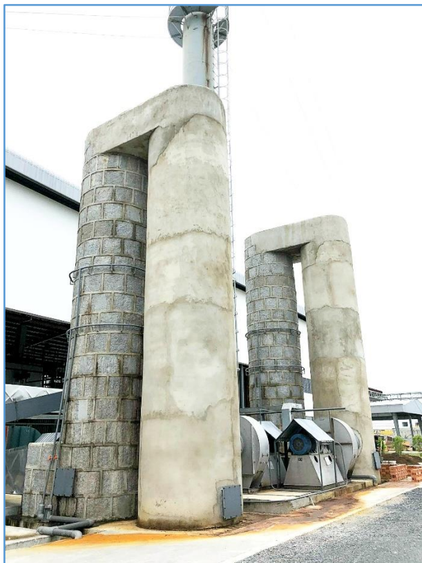
Hình 3.3 Ảnh hệ thống xử lý khí thải lò hơi và lò dầu tải nhiệt đã lắp đặt
